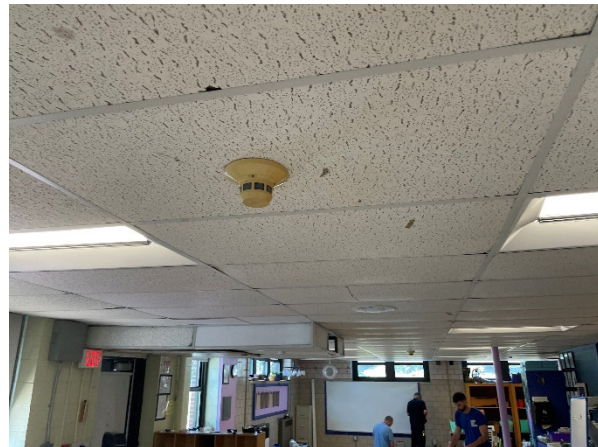
AV notification device and bell
