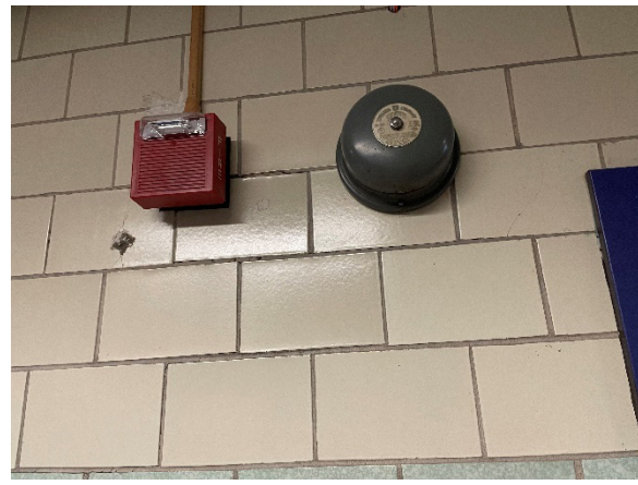
AV notification device and bell
